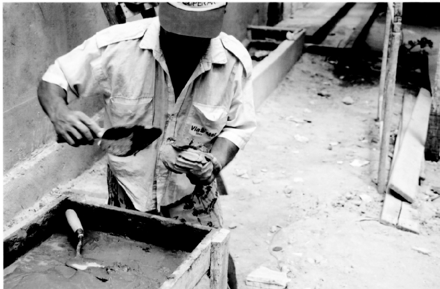
FIGURA 5 - FIXAÇÃO DAS PLACAS
